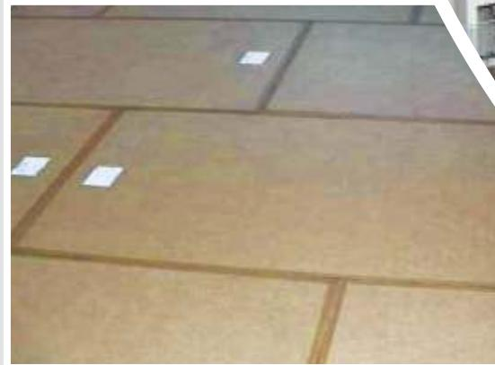
Desky Wolf se pokládají na sraz v řadách, jednotlivé řady potom s vazbou minimálně 100 mm. Licová strana označená štítkem směruje vždy do interiéru.
