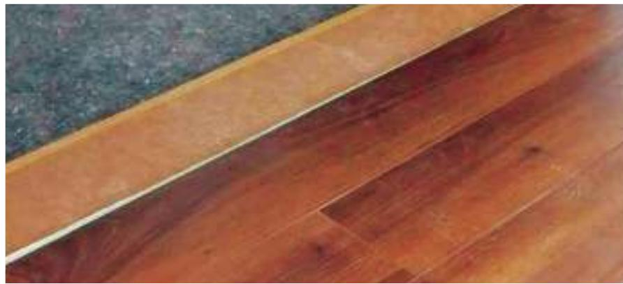
Rekonstrukce podlahy bytové jednotky, desky Wolf umístěné na separační textilii Wolf Multico 400. Finální vrstvu tvoří plovoucí podlaha s click systémem. Zlepšení kročejové neprůzvučnosti podlahové konstrukce je o 25 dB oproti původnímu stavu.
