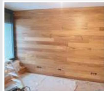
Stěna odhlučněná systémem W 40 s dřevěným obkladem.
