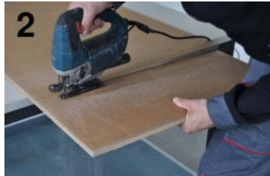
2 Formátování desky Wolf pomocí přímočaré pily. Další možností je použití kotoučové pily, rozbrušovačky nebo zalamovacího nože.
